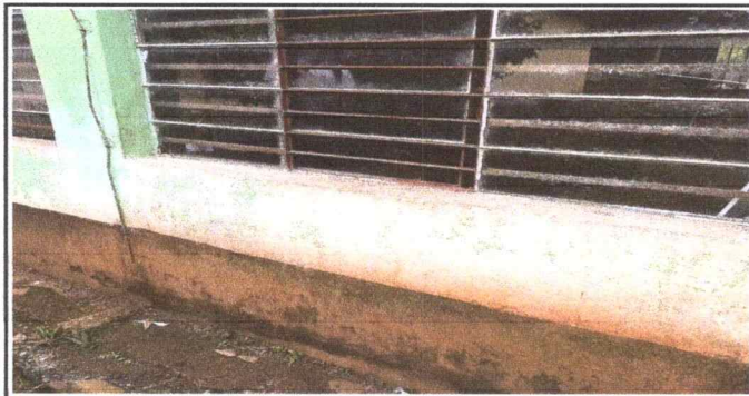
Foto 3: Sustitución de algunos vidrios esta en mal estado.
