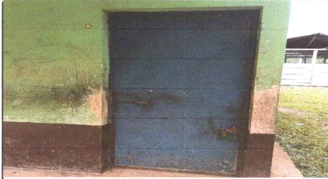
Foto 1. Mantenimiento de la puerta del modulo 1 y 2.
